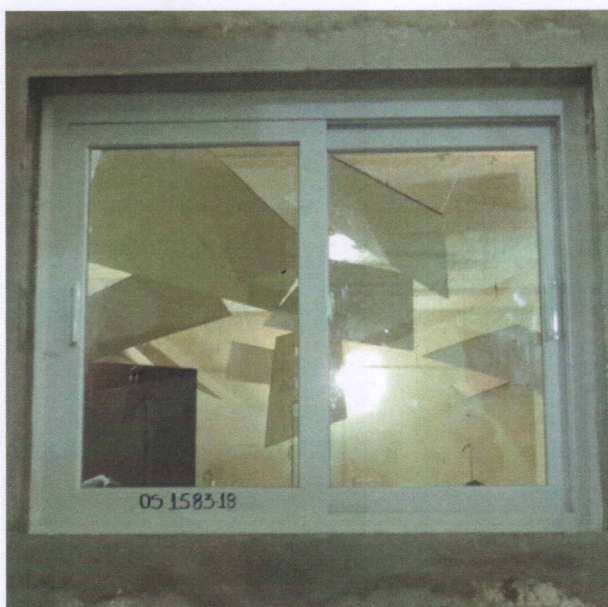
Foto 2: Janela instalada vista da câmara de recepção sonora.
